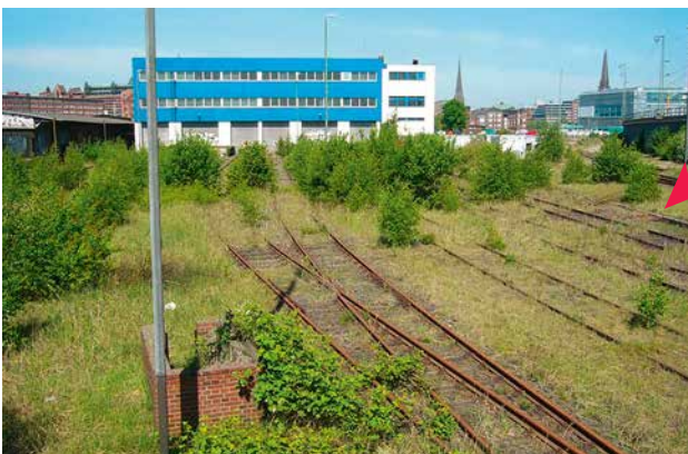
Unter Denkmalschutz gestellte Teile des Gleisverlaufs sowie die Bahnsteigkante von Bahnsteig 2 (s. Pfeil). Foto: Ulrich Prehn.
